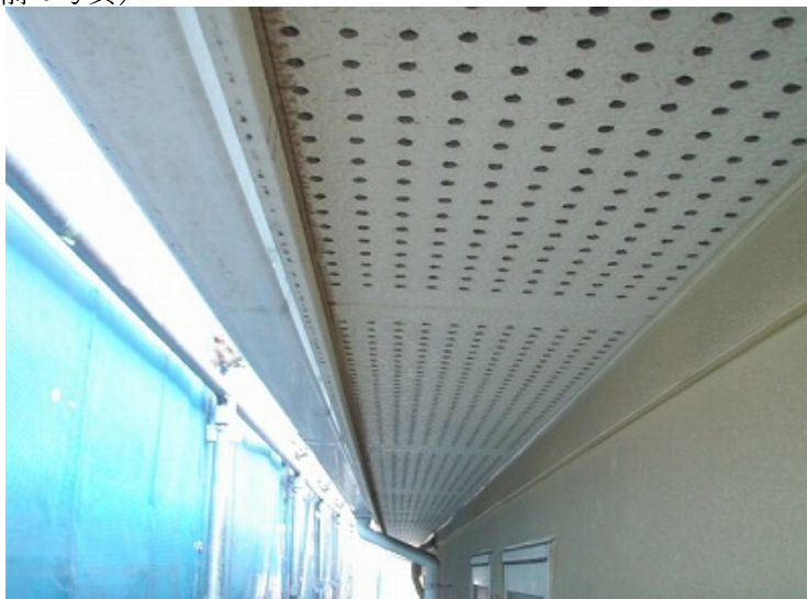
(施工前の写真)
