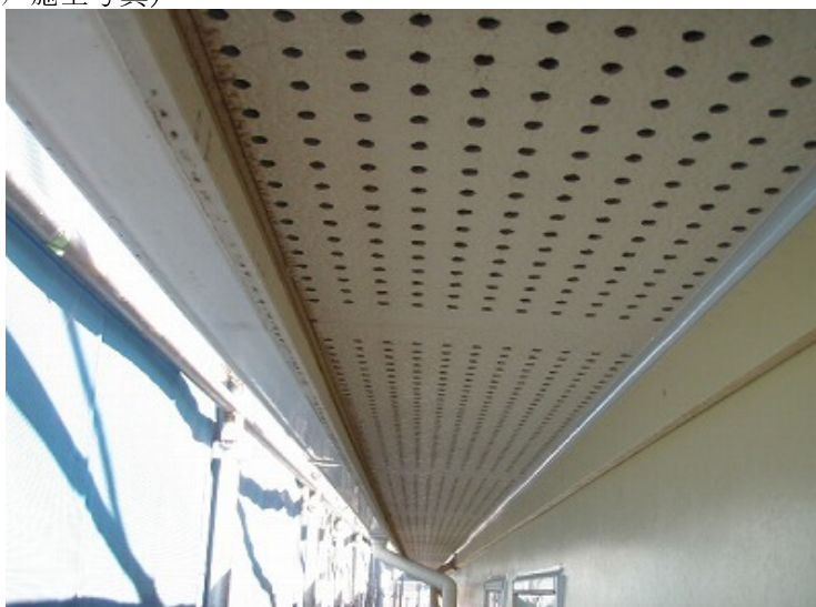
(シーリング 施工写真)
