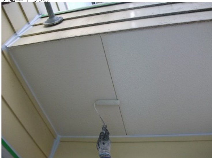
(下塗り施工中写真)
