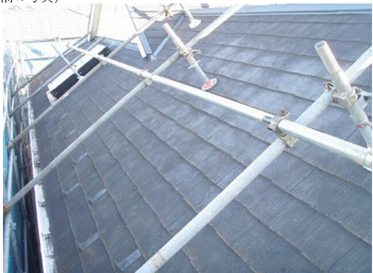
(施工前の写真)
