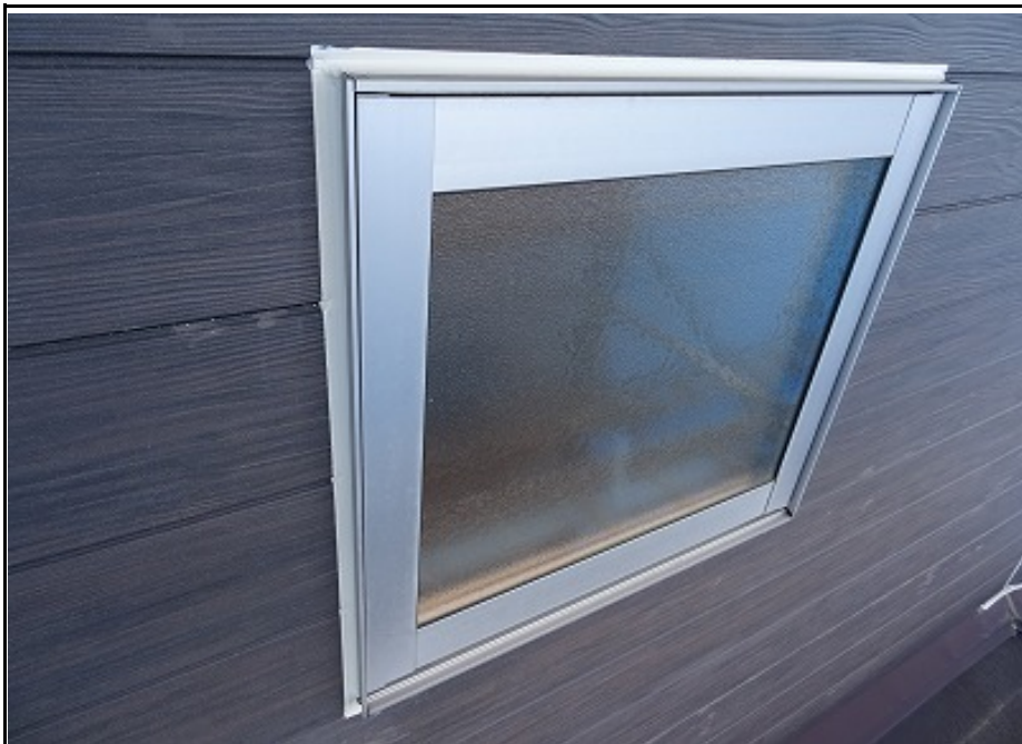
壁目地打ち替え (シーリング施工後)
