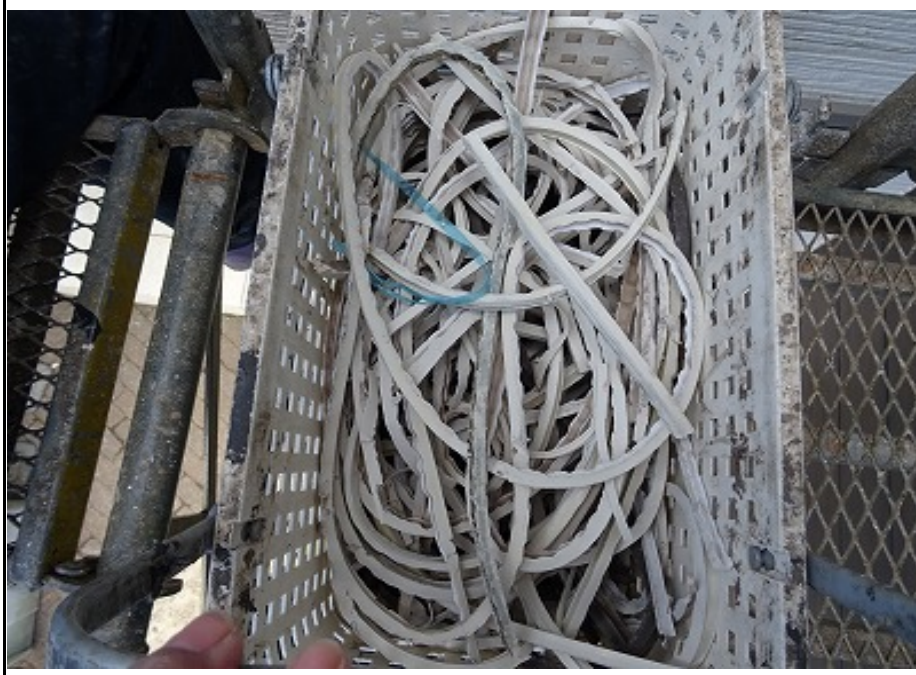
壁目地打ち替え (撤去中)
