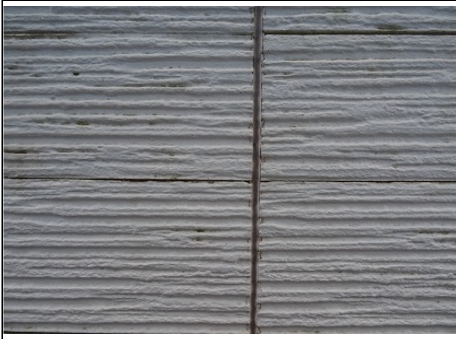
壁目地打ち替え (施工前)
