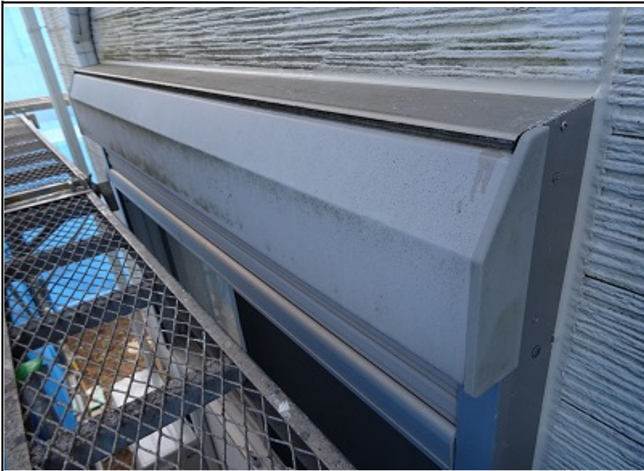
シャッターボックス (シーリング施工後)
