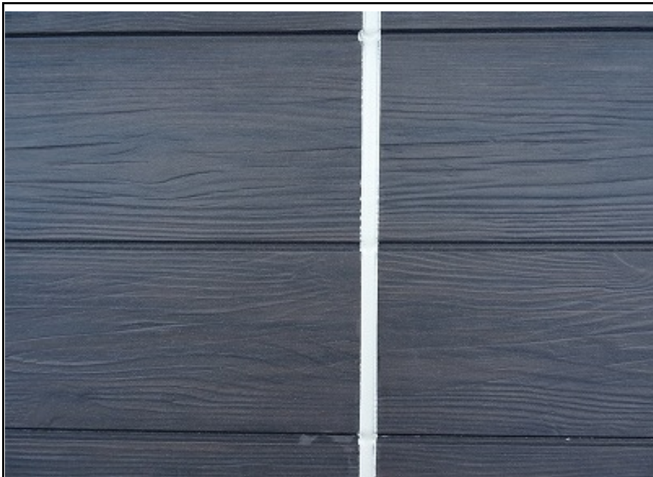
壁目地打ち替え (シーリング施工後)
