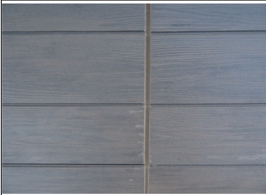
壁目地打ち替え (施工前)
