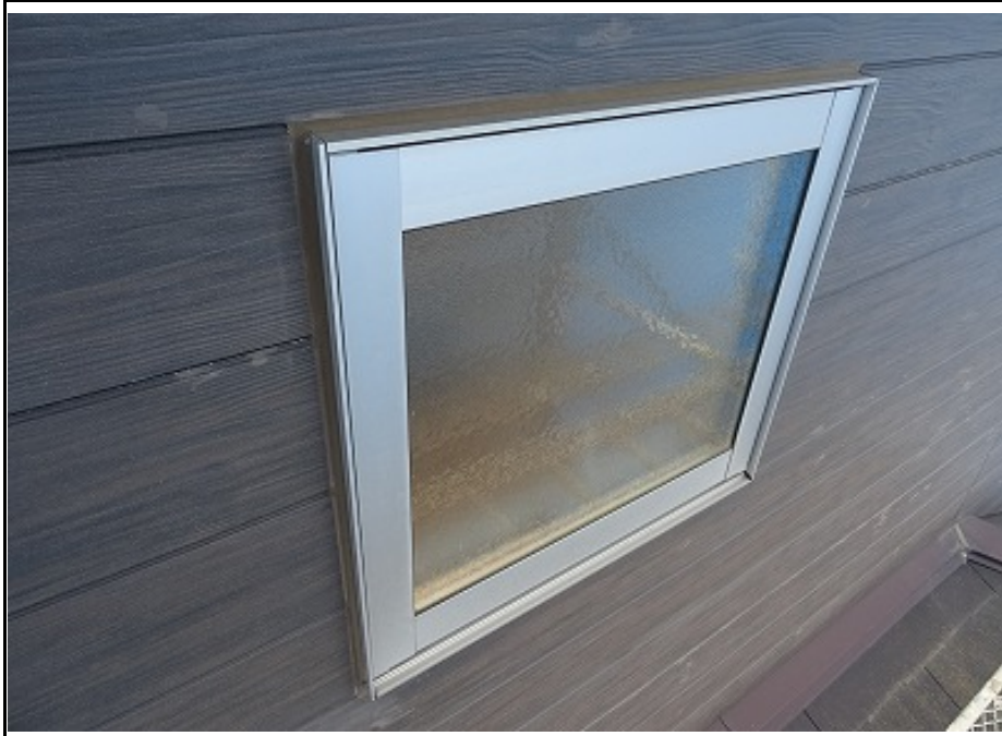
壁目地打ち替え (施工前)
