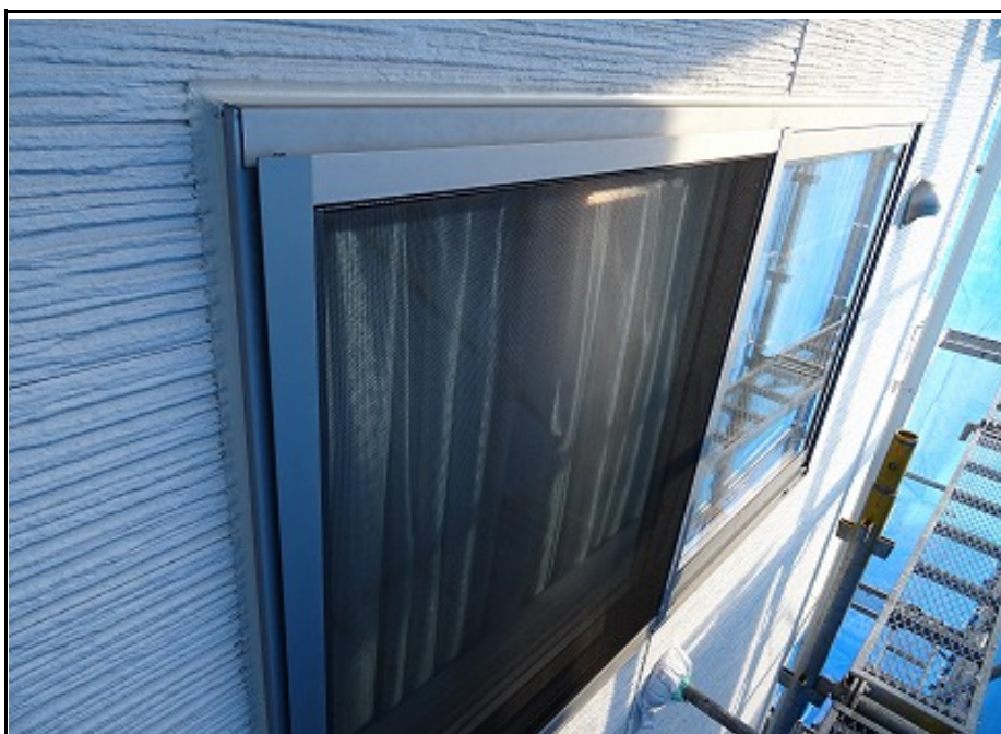
壁目地打ち替え (シーリング施工後)
