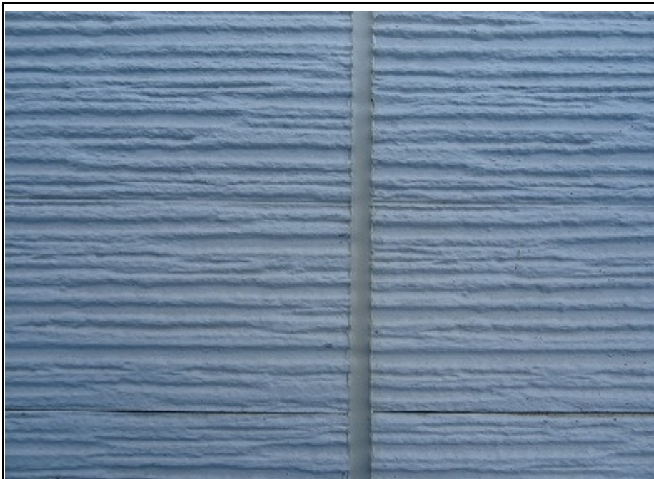
壁目地打ち替え (シーリング施工後)
