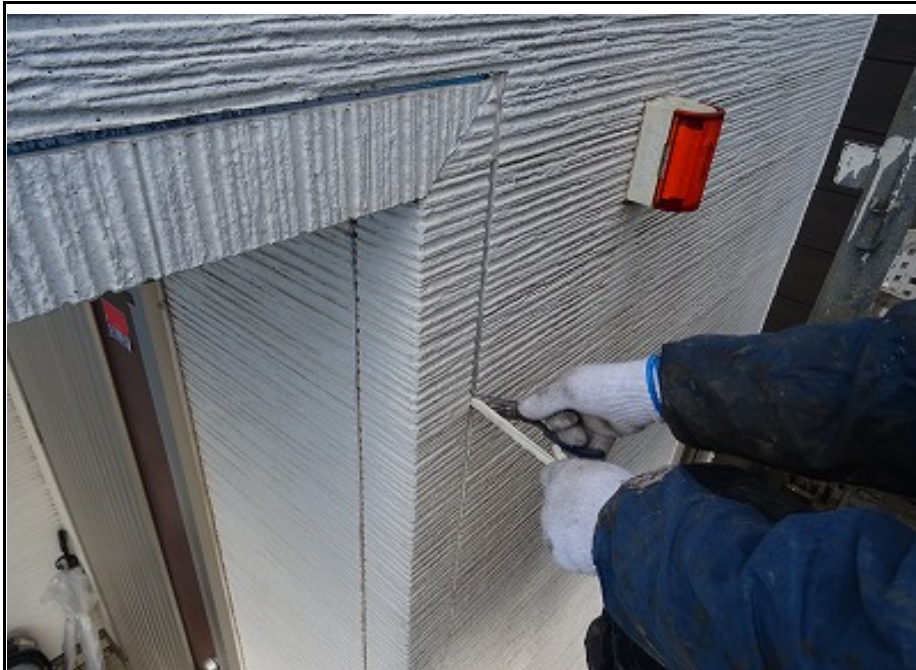
壁目地打ち替え (撤去中)
