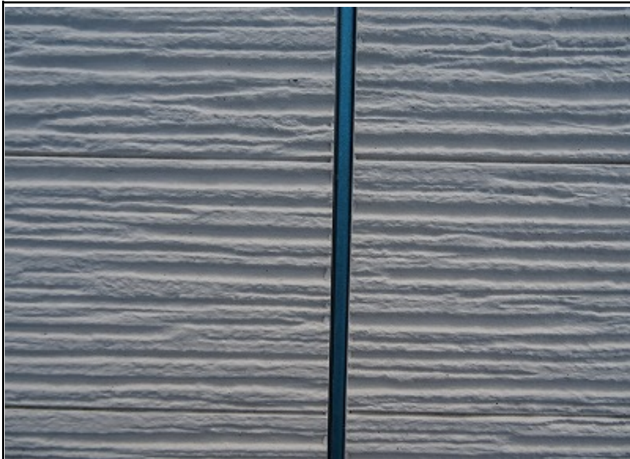
壁目地打ち替え (撤去後)
