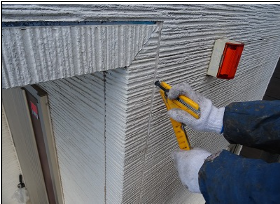
壁目地打ち替え (撤去中)
