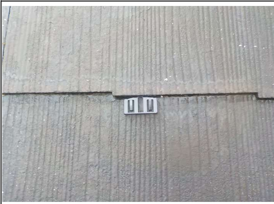
屋根 (タスペーサー投入)
