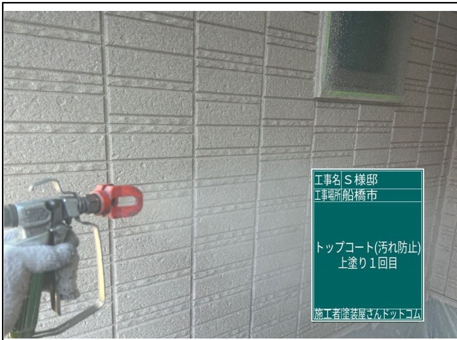
外壁 (トップコート上塗り1回目)
