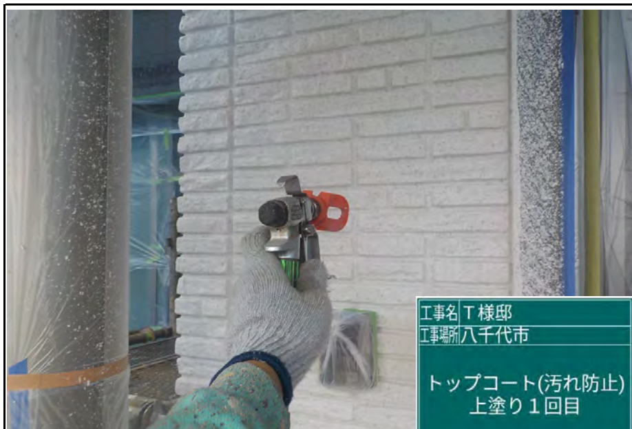
外壁 (上塗り1回目) ※トップコート仕上げ
