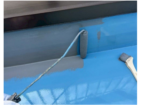
トップコート施工
