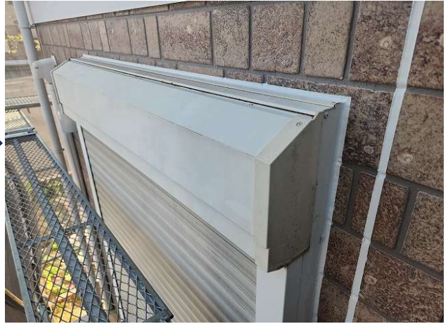
新規シーリング打設後
