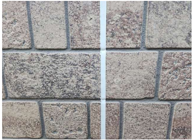
新規シーリング打設後
