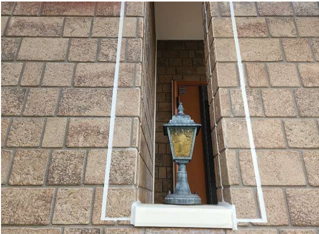
新規シーリング打設後
