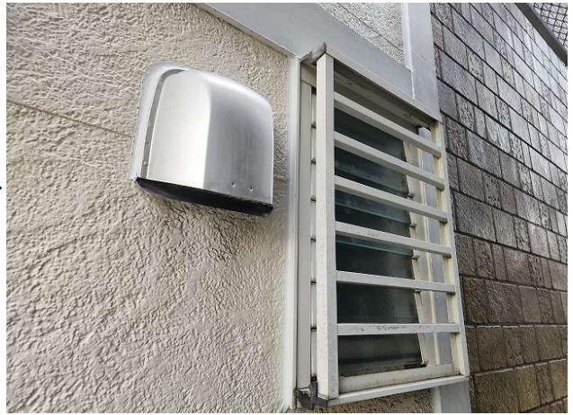
新規シーリング打設後
