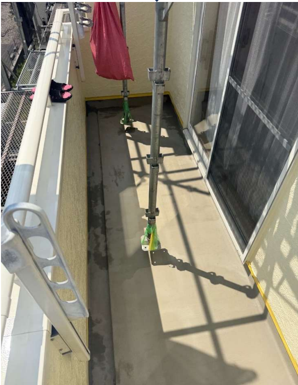
下地処理(カチオン施工)
