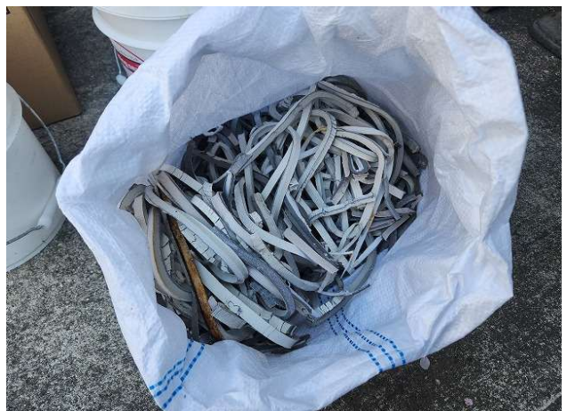
既存シーリング撤去ゴミ
