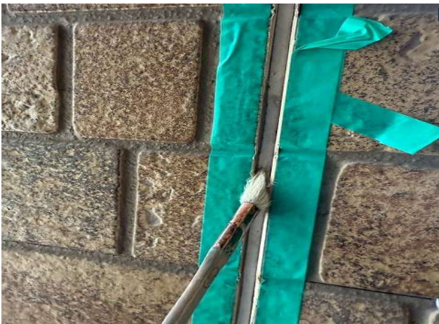
プライマー塗布
