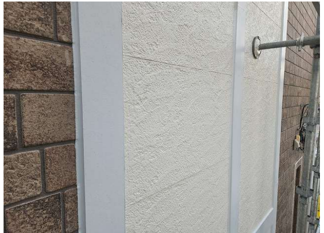
新規シーリング打設後
