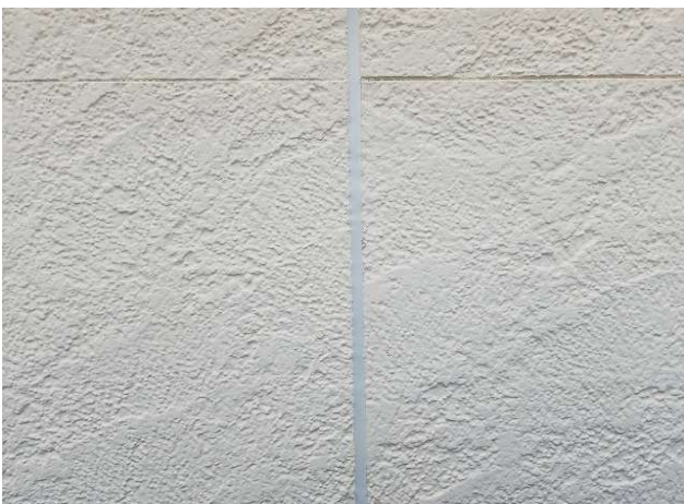
新規シーリング打設後
